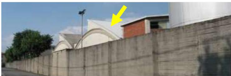
**Impossibilità di riconoscere coperture in cemento-amianto incapsulate o sovracoperte**
